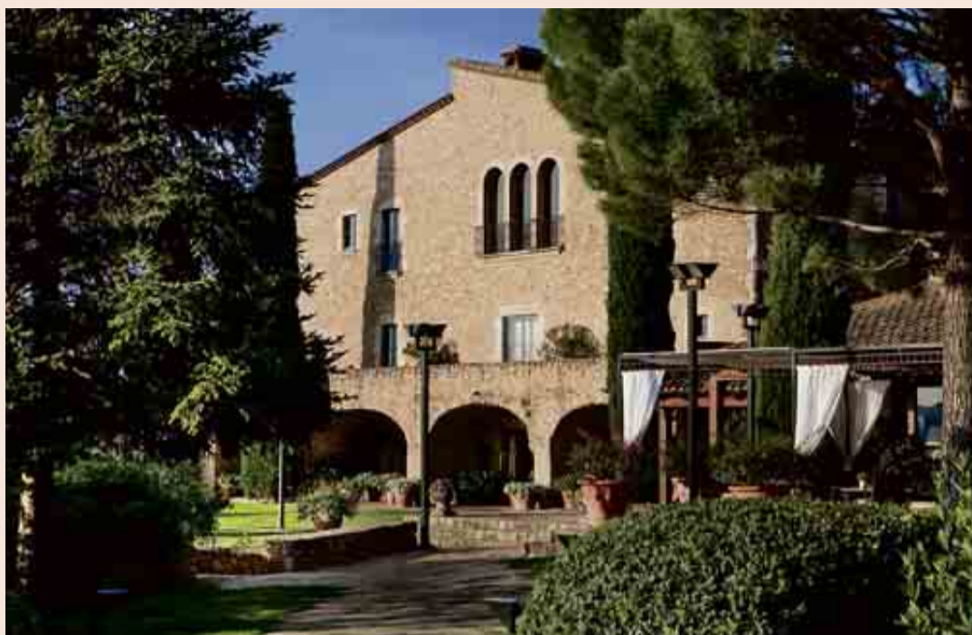
El hotel era una antigua masía del siglo XVIII. En su restauración, se conservaron la fachada y los arcos interiores.
